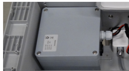
Ref. ITAMPCVS Estación de distribución
